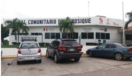
Hospital Municipal de Tenosique
